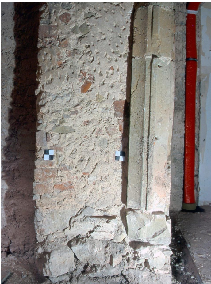
Bild 4: seitliches Fenstergewände mit abgeschlagener Bank in der südlichen Außenwand des Anwesens Georgengasse 6 im 1.OG. (Umbau Vermögenszentrum Sparkasse 2006). Dieses Fenster ist auf den Bildern 6+7 in der Südfassade des Hauses Georgengasse 6 in voller Größe vorhanden. (Foto Verfasser)
