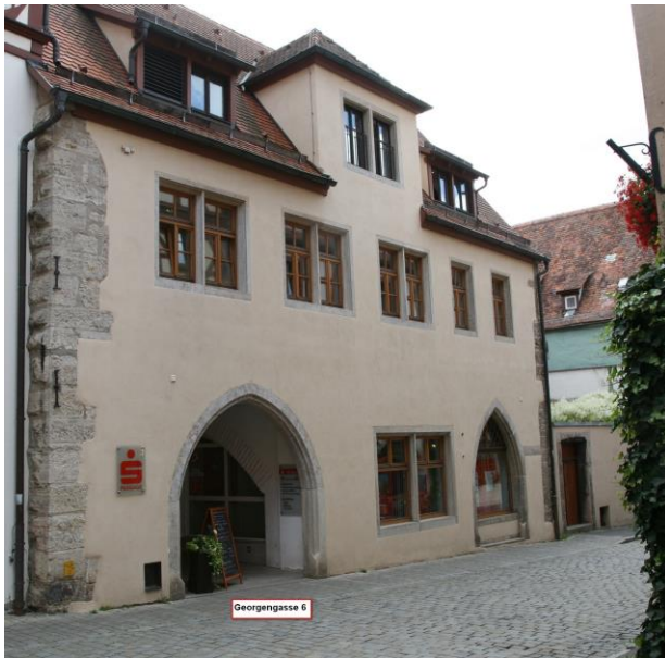
Bild 2: Heutiger Zustand Georgengasse 6 - mit der Eckquaderung.
