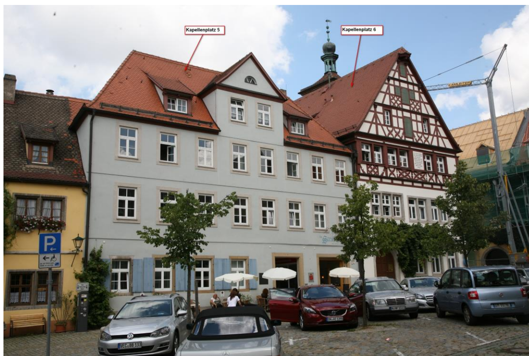
Bild 1: Heutiger Zustand- Nördliche Häuserzeile am Kapellenplatz – Südfassaden Kapellenplatz 5+6
